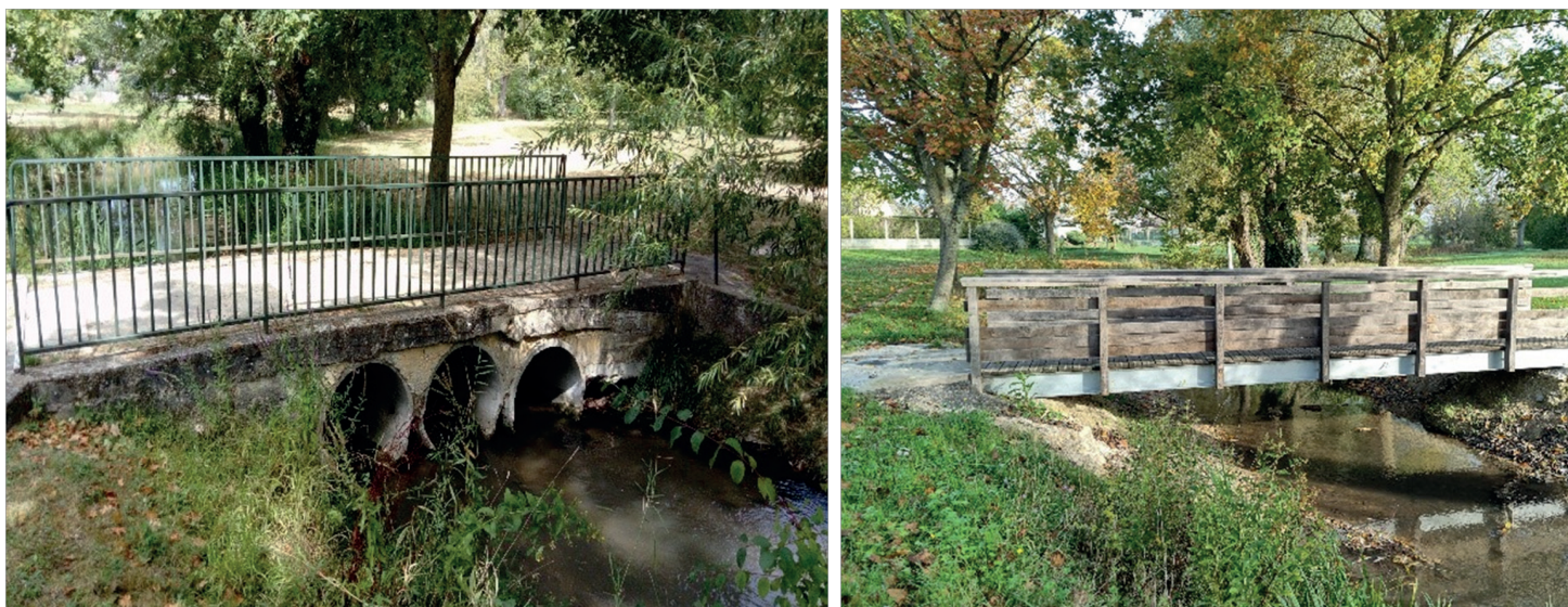
Ancien ouvrage de franchissement de la Blaise (à gauche) et nouvelle passerelle sur le site des Grévières (à droite).
