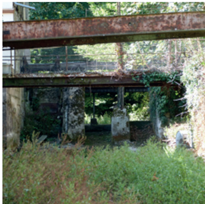
Ouvrage hydraulique sur la Coole au niveau du domaine d'Ecury sur Coole
