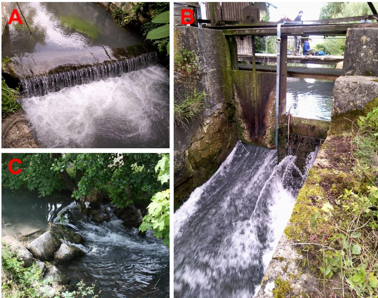
*Figure 6 : Photo des différents types d'ouvrages ; A) Ouvrage vertical (Seuil du bief en rive gauche du moulin du bas à Pogny), B) Ouvrage incliné (Vannage du moulin du lieu dit "Le Moulin" à Pogny), C) Ouvrage en enrochement (Seuil en aval du pont à Nuisement)*
