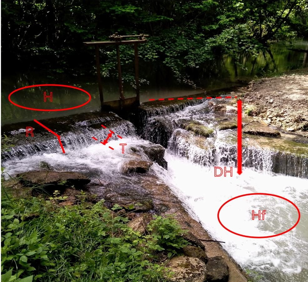
Figure 5 : Schéma de différents paramètres à mesurer sur un ouvrage (vannage du bief en rive droite du moulin bas de la Moivre à Pogny)
