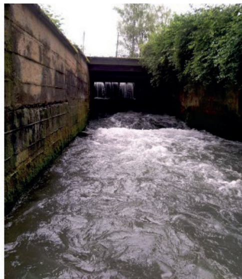
Ouvrage de classe 0, infranchissable pour la truite fario hors événement de crue exceptionnelle en raison d'une hauteur de chute trop importante (le moulin des Ormes à Francheville)
