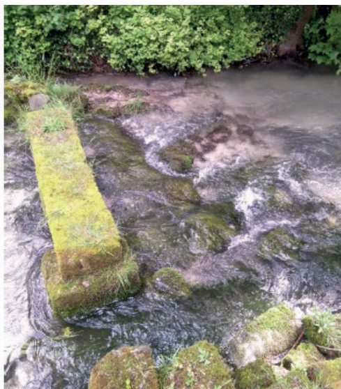
Ouvrage de classe 1, peu contraignant pour le franchissement de la truite fario (ancien seuil sur la commune de Moivre)
