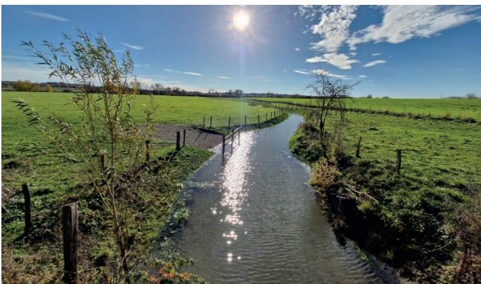
Annexe hydraulique restaurée (05/11/2025) - Source FDAAPPMA51
