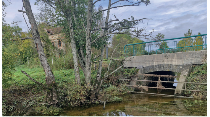
Pont de la RD 66 avant travaux vu depuis l'amont - Source SMAVAS
